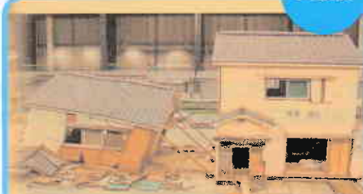
耐震補強未実施の建物
